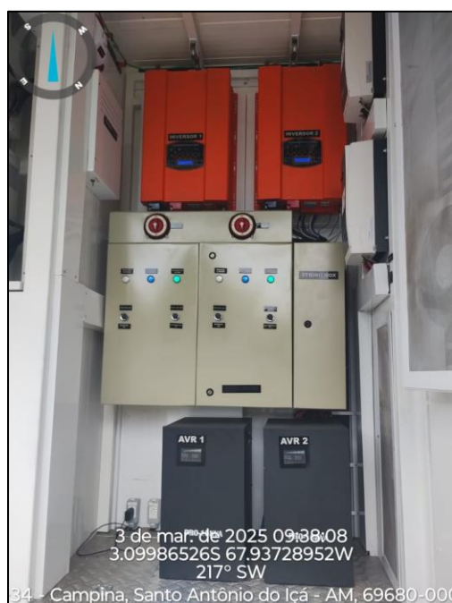
g) Figura 07 – Manutenção na área de energia.
